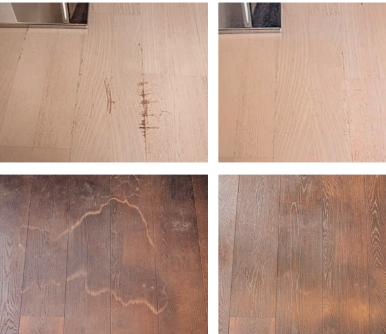
Kratzer in der Farbschicht der Parkettoberfläche vor und nach der Behandlung.
