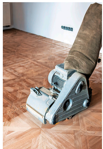
0,5 bis 0,7 mm Holz werden mit der Schleifmaschine abgetragen. BILD ISP
