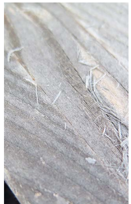
Delignifizierung an der Dielenoberfläche.
