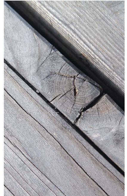
Fugen innerhalb der Bretter.
