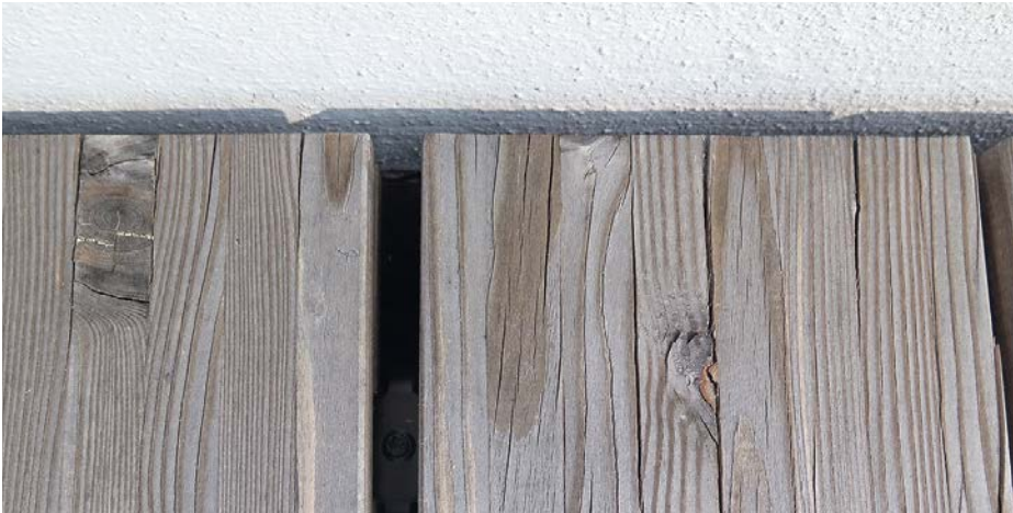
Offene Längsstöße stirnseitig der Dielen.
