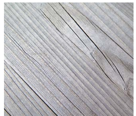
Tolerierbare Risse ohne Beeinträchtigung der Nutzung.
