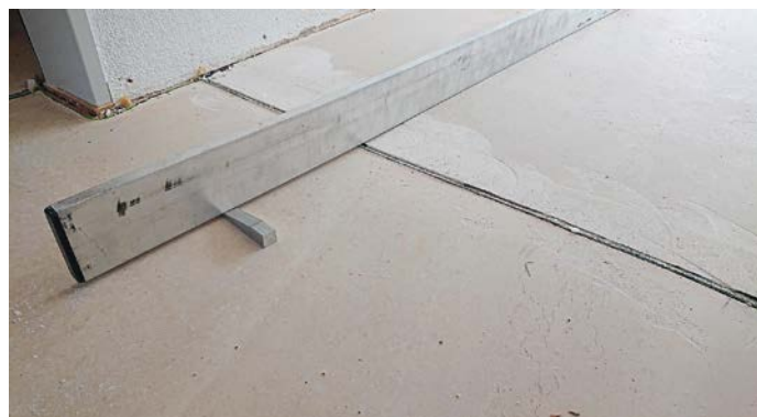
Höhendifferenz bei Durchgang und Bewegungsfuge.
