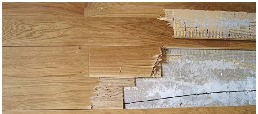
Risse im Estrich durch Überbelastungen aus dem Holz.
