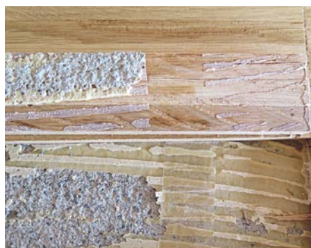
Ungenügende Verklebung wegen Klebband sowie zu geringer Leimmenge.
