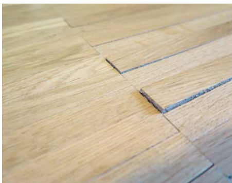
Mehrere Klötzchen mit Verformungen und Höhendifferenzen.
