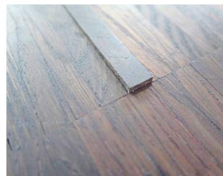
Teilgelöste Lamelle mit Aufwölbung stirnseitig.
