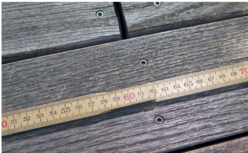
Das Lattenachsmass ist zu gross.
