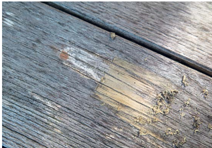
Eliminierung der Verfärbung durch Abschaben.
