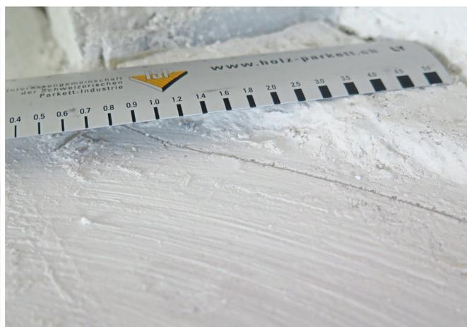
Zu weicher Calciumsulfat-Fließestrich, festgestellt beim Reinigungsschliff mit der Einscheibenmaschine.
