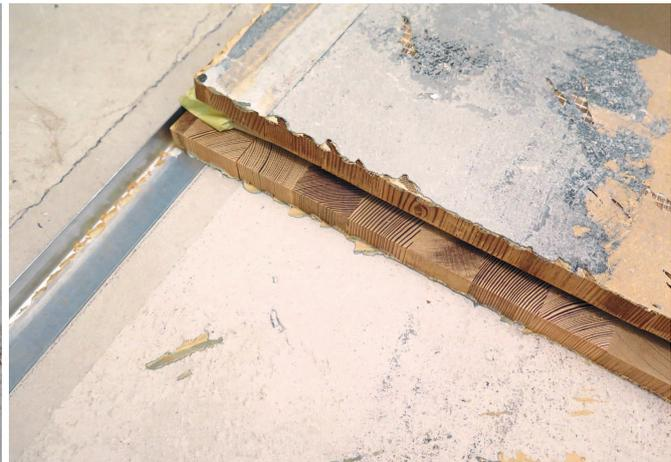
Puderschicht auf Calciumsulfat-Fließestrich wirkt wie Trennfilm zwischen Leim/Spachtelmasse und Estrich.
