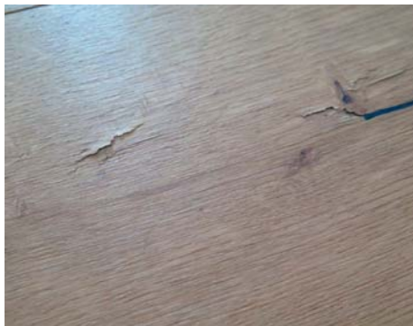
/ Schilfferrisse haben schieferartige Absplitterungen, welche für Nutzer sehr gefährlich sein können.
