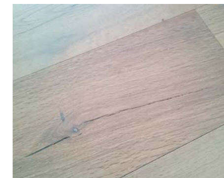
Tolerierbare Trockenrisse entstehen durch übermässige Austrocknung und durch große Schwindspannungen.
